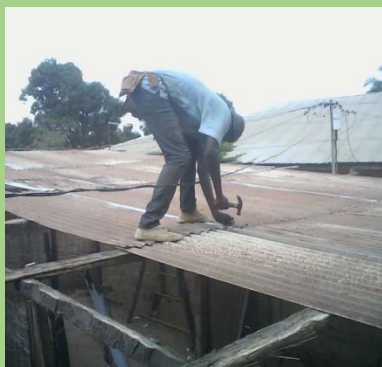
Colocação do telhado em chapa zincada na escola de Lala-Quema
