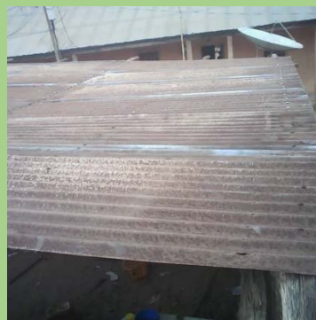
Colocação do telhado em chapa zincada na escola de Lala-Quema
